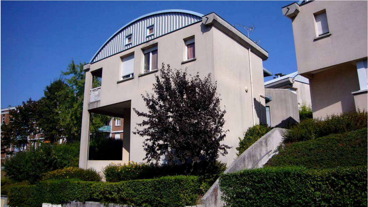
Image 5 – La rénovation de la cité-jardin – mlf
